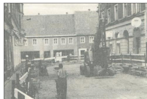
schaft gezogene Röderstraße wird grundhaft erneuert. Dabei werden sämtliche Hausanschlüsse für Abwasser, Regenwasser und Trinkwasser ausgewechselt, der Hauptsammler wird von innen saniert. Auf dem neu einzubringenden Unterbau wird das traditionelle Großpflaster verlegt, da innerhalb der nächsten zwei Jahre die Röderstraße für den Durchgangsverkehr gesperrt und zur Fußgängerzone umgestaltet wird.
