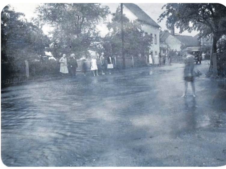
Bei Hochwasser fließt der Dorfbach noch entlang der Hauptstraße - hier am 1. August 1932.
