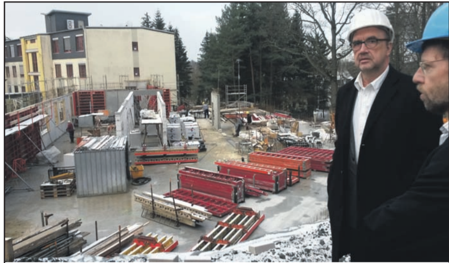
Im Erdgeschoß dieses Neubaus wird die Ambulanz des MZEB entstehen, erklären Geschäftsführer Martin Wallmann und Chefarzt Dr. Thomas Mayer. (v.li.n.re.)
