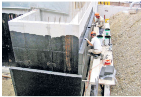
Beim energieeffizienten Bauen kommt es nicht nur auf Dämmung und Heizung, sondern auch auf die versteckte "graue Energie" an, also die Energie, die insgesamt für die Errichtung des Gebäudes aufgewendet wird. Foto: djd/foamglas
