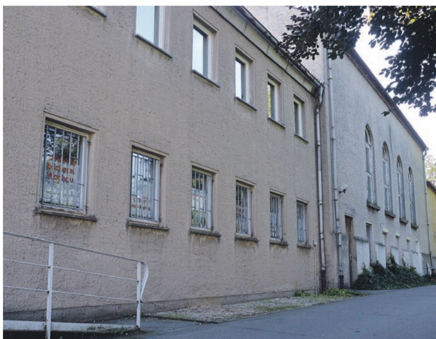
Die alte Turnhalle beherbergt momentan die Gemeindebücherei und eine Zahnarztpraxis. Geplant sind eine komplette Sanierung und der Umbau zur neuen Gemeindeverwaltung.
