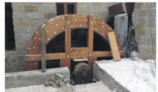
alten Wasserrad, eingefädelt werden und anschließend wurde das Rad mit Holz und Keilen auf die Welle aufgesetzt. Nun wartet es noch auf das Wasserbett und die Antriebstechnik zur Mühle muß auch wieder anmontiert werden. Spätestens zum „23. Deutschen Mühlentag“ am 16.05.16 soll die Turbine mal zuge dreht bleiben, damit die Mühle endlich wieder von einem richtigen Wasserrad angetrieben wird.
