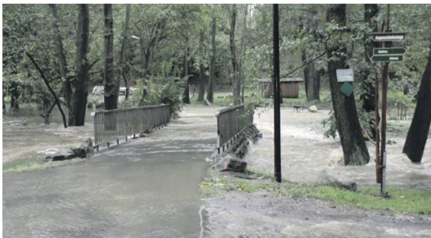
Insbesondere durch das Hochwasser im Jahre 2010 hat die Brücke über die Röder vor der Hüttermühle Beschädigungen an den uferseitigen Bereichen genommen.
