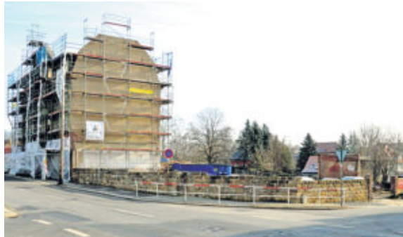
Momentan wird an dem bestehenden Wohnhaus Pulsnitzer Straße 40 schon mit Hochdruck gebaut. Der Dachstuhl wurde komplett entfernt. Später reißen sich weitere Wohnhäuser an den Altbau.
