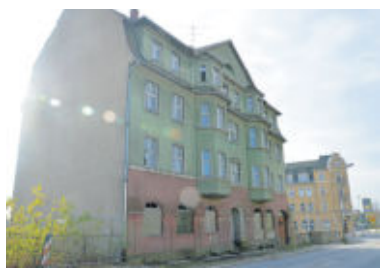
Im Herbst vergangenen Jahres konnte man erste Arbeiten auf dem Areal beobachten. Das langjährige Gerüst verschwand und die Fassade wurde sichtbar.
