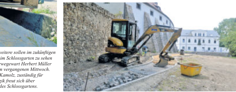
Die Wege sind bereits angelegt und erste Ergebnisse des Baufortschrittes sind sichtbar.
