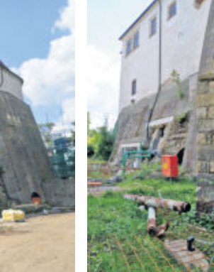
Die Bauarbeiten sind in vollem Gange. Für den Anbau des Aufzuges wurde bereits Platz geschaffen.
