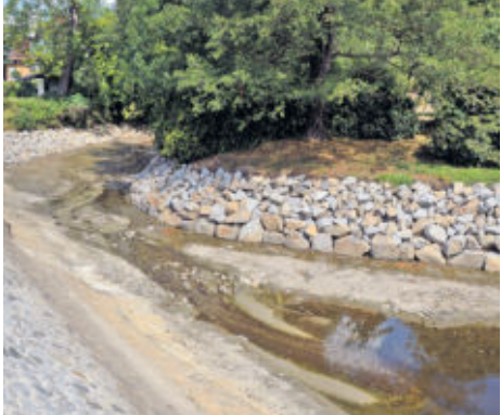
Niedrigwasser im Schlossteich. Das liegt aber nicht an den heißen Temperaturen sondern an den Arbeiten zum Entschlamm.
