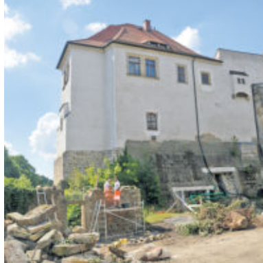
Die Bauarbeiten sind in vollem Gange. Für den Anbau des Aufzuges wurde bereits Platz geschaffen.
