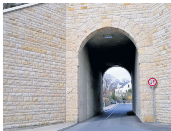
Die Straßenbaumaßnahme ist beendet, eine Durchquerung des Viadukts ist wieder möglich. FOTO: Martina Gebauer
