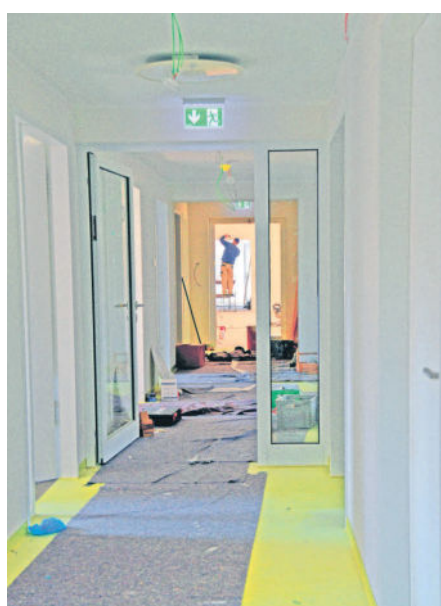
Noch sind die Handwerker in den Fluren unterwegs und sorgen für den letzten Schliff.
