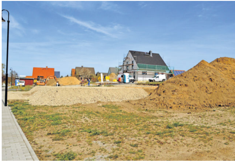
Die ersten Häuser werden bereits auf den Grundstücken gebaut, weitere werden wohl bei dem bauoffenem Wetter schnell folgen.
