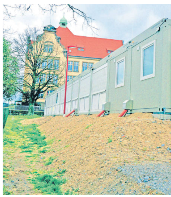
Die Stahlkolosse am Ferdinand-Sauerbruch-Gymnasium in Großröhdsdorf wurden direkt gegenüber dem Schulgelände am Busbahnhof platziert und mit den nötigen Medien angeschlossen.
