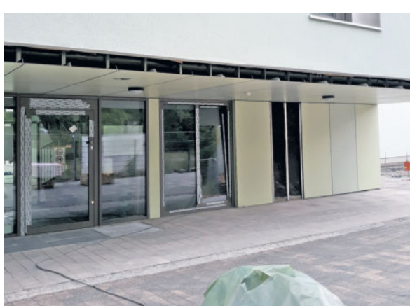
Auf dem Grundschulareal wurde ein Komplex aus drei nebeneinanderstehenden Pavillons errichtet. FOTOS: Gebauer
