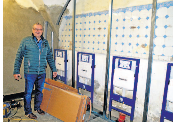
Lothar Israel unterstützt den Neubau der Kellertoilette und schaut ab und an mal nach dem Rechten auf der Baustelle.
